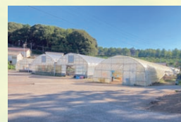
ご利用者が安全に「しごと」ができるように地面の舗装工事をしました
