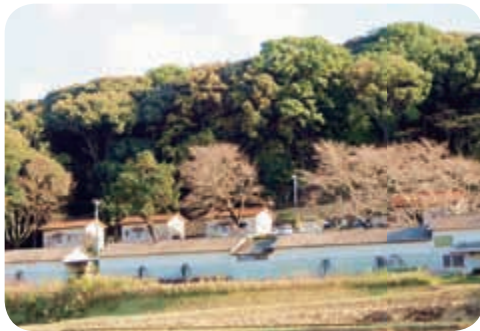
令和元年12月 夫婦村解体前日 (赤い屋根の建物)
